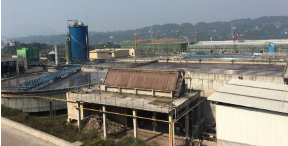
图 3-1 四川金田纸业有限公司污水处理站现状
